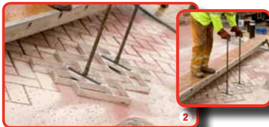
2 La sabbia viene distribuita sul materiale per fissare lo stampo mentre il modello viene impresso
