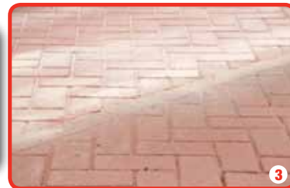
3 Dopo circa un'ora, la superficie è pronta, la sabbia in eccesso viene rimossa e l'area riaperta al traffico
