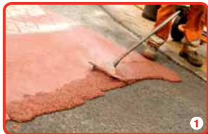
1 Imprint caldo è steso in modo uniforme sulla superficie
