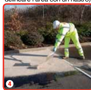
4 L'aggregato selezionato verrà poi distribuito sopra al mix di resine
