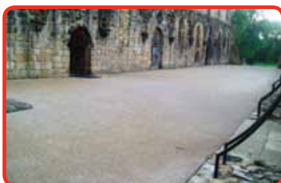
1 La superficie deve essere ripulita dai detriti prima di essere trattata (eventualmente delimitare l'area con un nastro)
