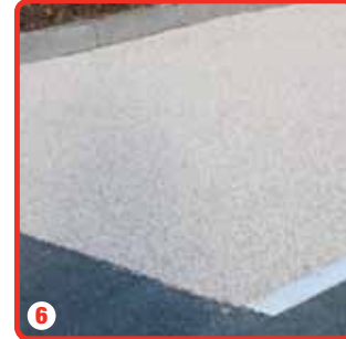
6 Dopo l'eventuale rimozione del nastro, la superficie sarà così completata
