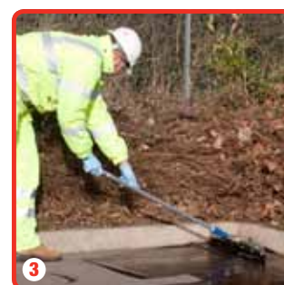
3 Il mix di resine andrà steso sopra l'area da ricoprire
