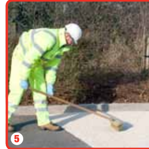
5 Dopo la stesura del mix, l'aggregato in eccesso viene spazzato via
