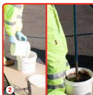
2 Un agente solidificante è aggiunto alla resina e miscelato accuratamente
