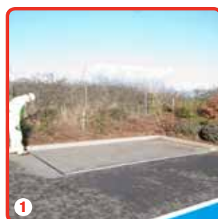
1 La superficie deve essere ripulita dai detriti prima di essere trattata (eventualmente delimitare l'area con un nastro)
